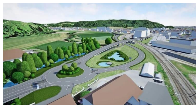
Umfahrung Suhr: der Beginn der Ostumfahrung vor der Bahnbarriere
